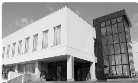
『公民館駐車場』の隣 白い建物です！
